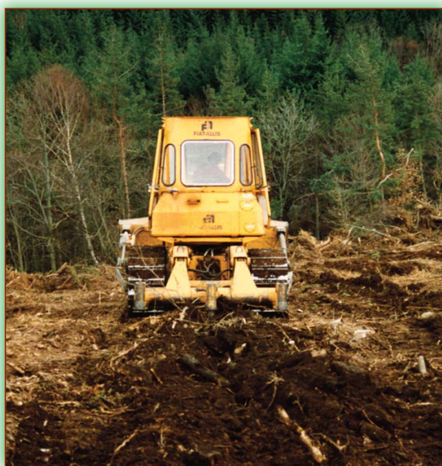
Sous-solage - DRAAF Auvergne
